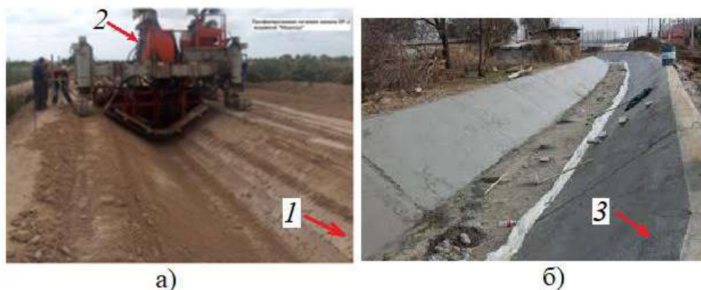
2 - расм. Канал ўзанини бетонлашга тайёрлаш:
